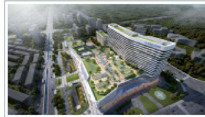
新昌县人民医院迁建工程项目
