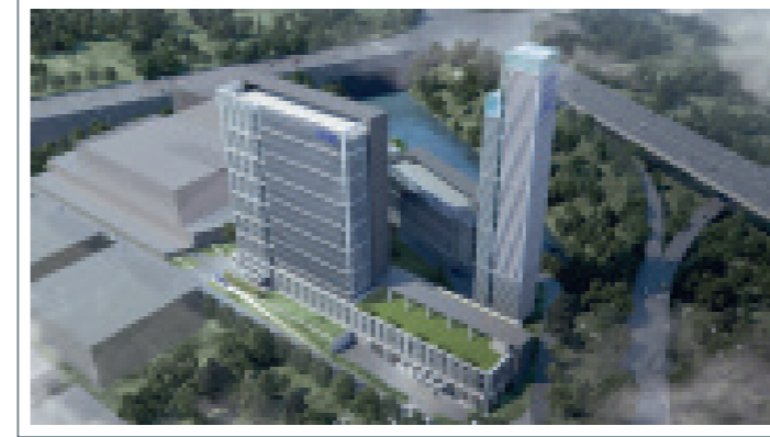
深圳市特种设备安全检验检测基地项目
