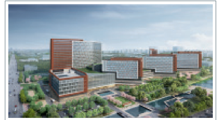
浙大二院萧山院区一期项目
